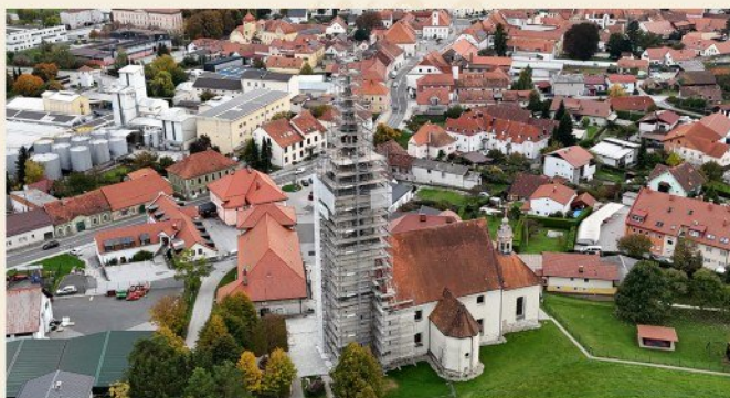
Zvonik s postavljenim gradbenim odrom jeseni leta 2025 (foto: Samo Mikulič)
